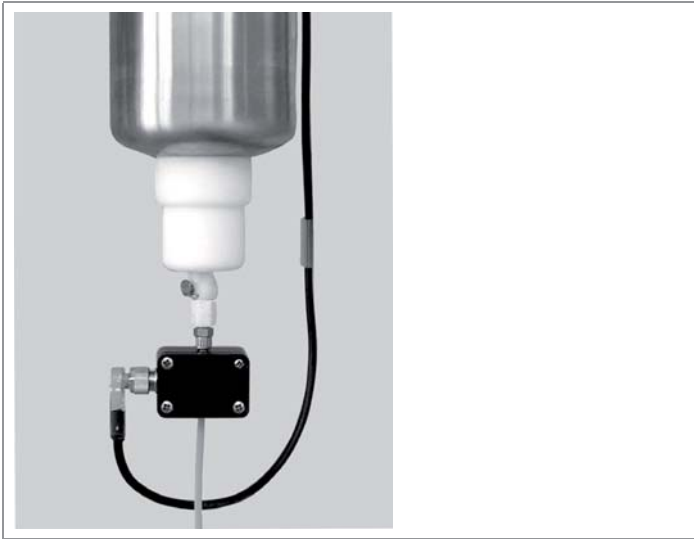
Fig. 4 : Installation du détecteur de niveau d'électrolyte sur le tube flexible.
